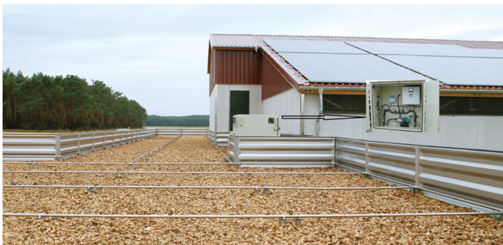
Abb. 3.1: Biofilter mit Steuerungseinheit im Bildausschnitt (© HAGOLA® Biofilter GmbH)
