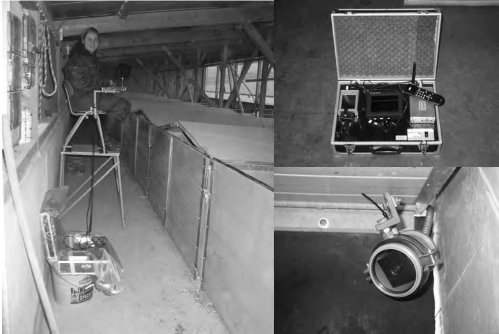
Abb.: 1, 2, 3: links: erhöhter Beobachtungsstuhl mit Monitor; rechts: Videokoffer mit Empfangsantenne + Kamera left: raised observing chair with monitor; right: video case with receiving aerial + camera
