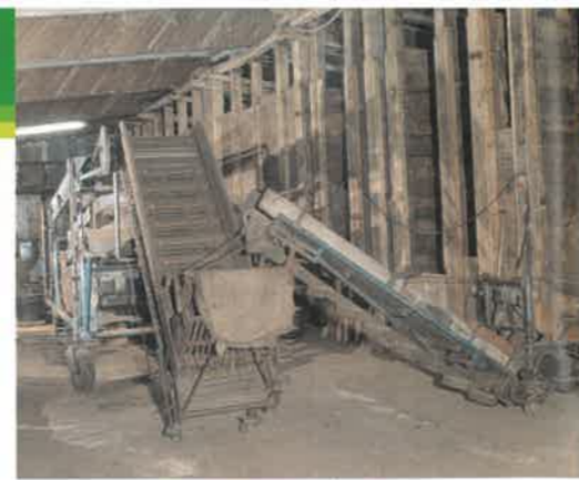
Sockelboxen ermöglichen die Auslagerung der Kartoffeln mit einem Förderband, das in den Belüftungskanal geschoben werden kann
