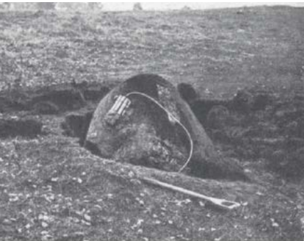
Zur Sprengung vorbereiteter Findling (RKTL 1936)
