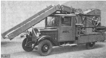
Kornverlust-Prüfwagen des RKTL – eigens für Mähdruschversuche erstellt (RKTL 1930b)
