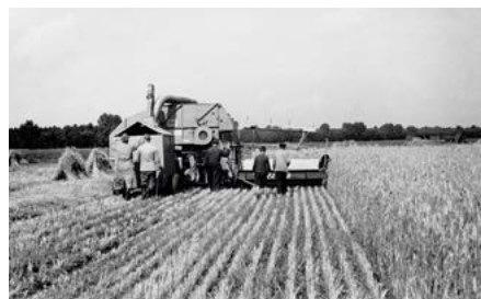
Ein gezogener Mähdreschbinder (MDB) der Firma Claas aus Harsewinkel mit Spreusammelwagen im Einsatz (© ATB-Collection | https://mediatum.ub.tum.de/1544658;1544630 )
