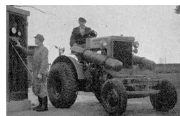
Biogas-Großanlage in Allerhop bei Soltau und mit Biogas betriebener Schlepper und Kompressoranlage (KTL 1952b)
