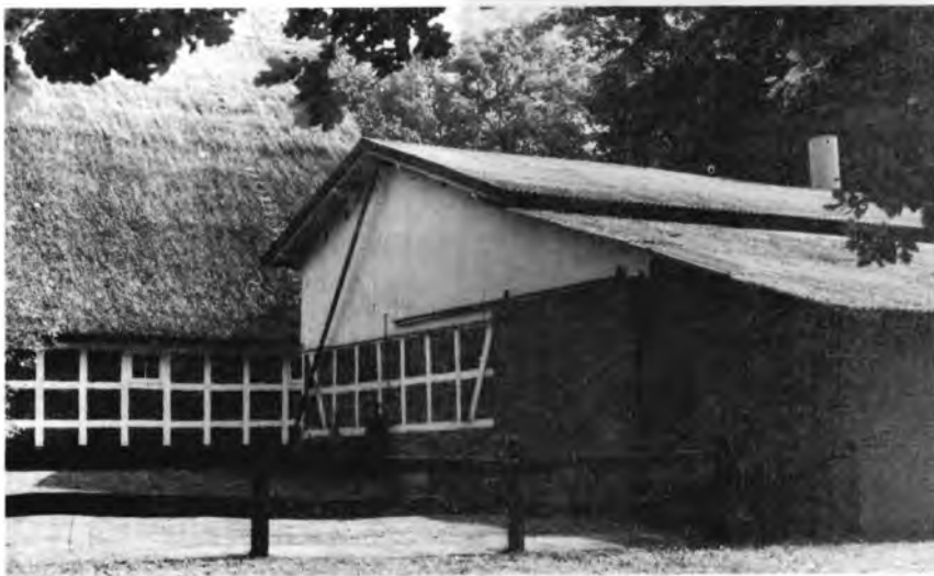
Abb. 3: Durch die Scheunentore und die fehlenden Fenster bleibt der Charakter einer Scheune erhalten
