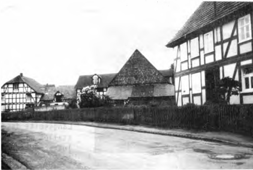
Abb. 1: Von Fachwerkbauten geprägtes Ortsbild
