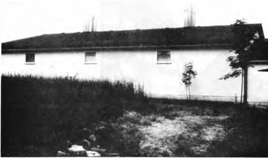
Abb. 4: Längsseite des Mast- stalles mit hohen Ab- luftschächten
