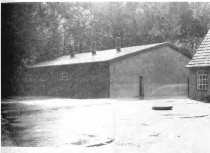
Abb. 2: Der neue freistehende Endmaststall fügt sich durch die Ziegelbauweise gut in das Hofbild ein
