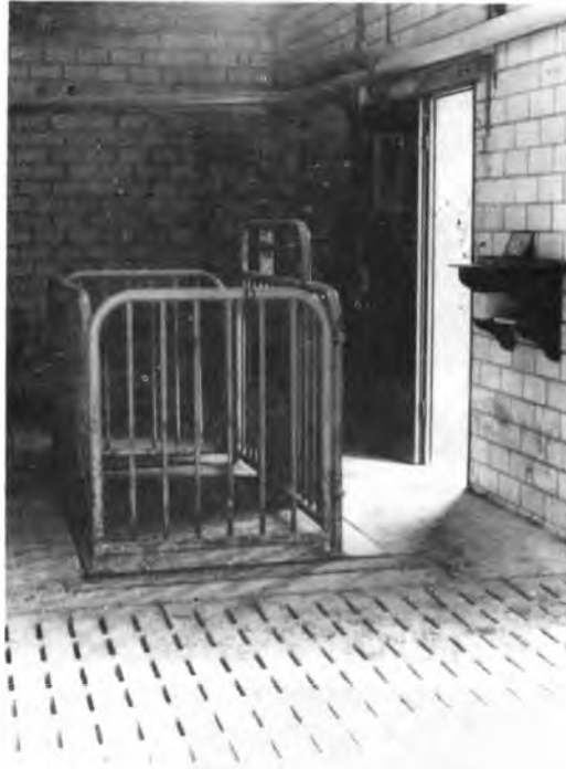
Abb. 4: Die eingebaute Waage im Vorraum grenzt an den Spaltenboden
