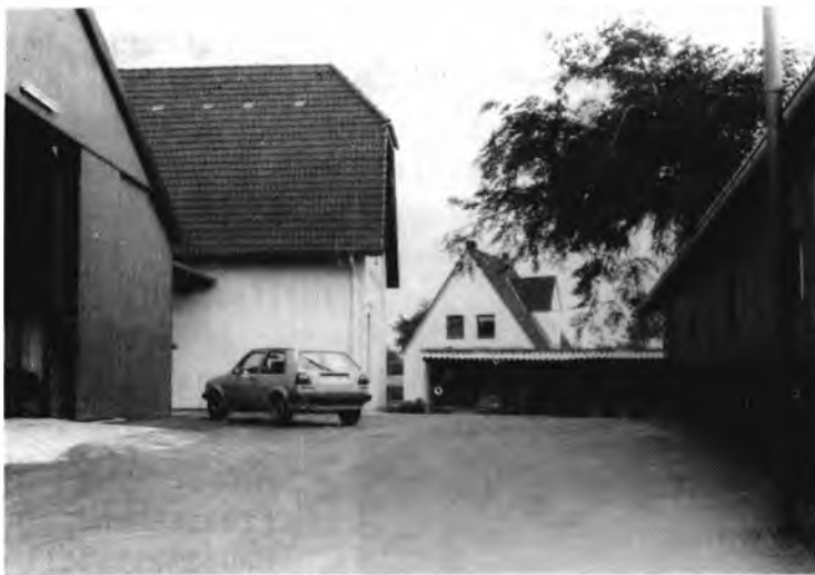
Abb. 5: Wohnhaus und Maschiner- halle im Vordergrund; rechts der umgebaute Vormaststall
