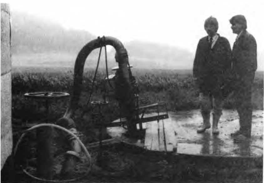
Abb. 6: Güllebehälter, Vor- grube und Pumpe, Rück- laufleitung und zwei Spindelschieber
