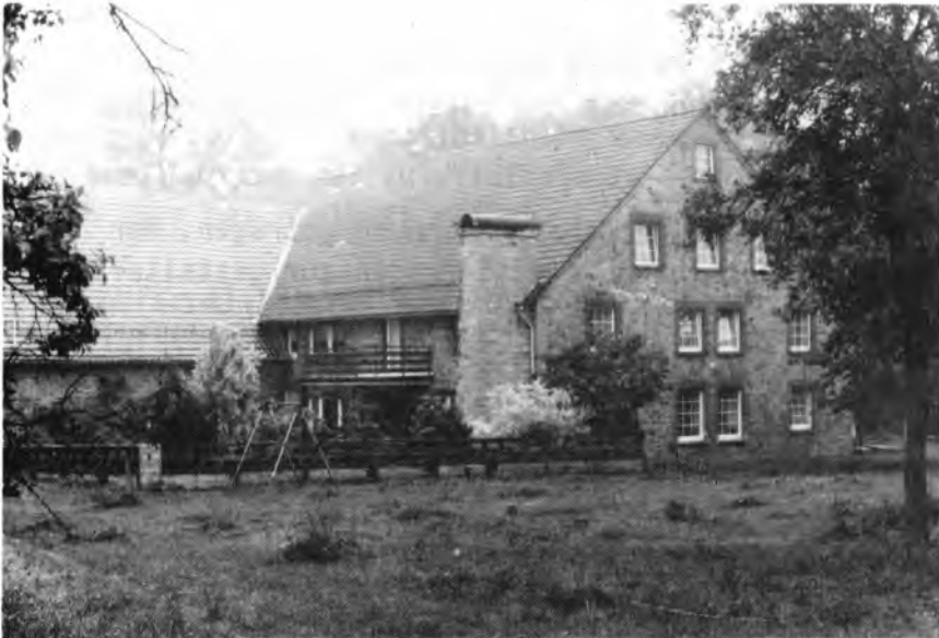
Abb. 1: Wohnhaus und altes Wirtschaftsgebäude aus Wesersandstein errichtet
