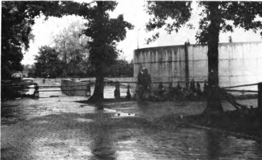
Abb. 5: Der Gülle-Hochbehälter mit 600 m 3 Inhalt sCHAFFT Lagerkapazität für 8 Monate
