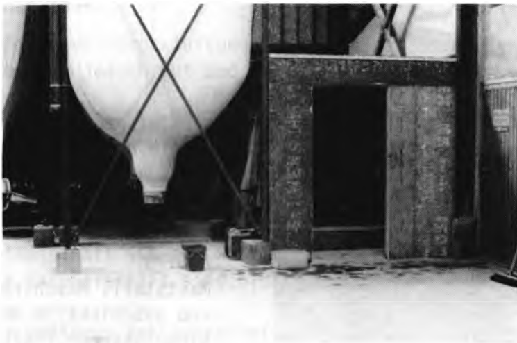
Abb. 6: Die Maschinenhalle umfaßt zugleich das Futterlager und einen abgetrennten Raum für die Steuerungstechnik
