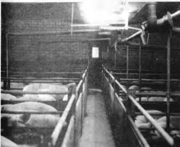
Abb. 3: Endmaststall mit Teil- spaltenboden, Flüssig- fütterung und Quertrog; zentraler Zuluftkanal über dem Kontrollgang mit beidseitig ange- brachten verstellbaren Luftleitplatten
