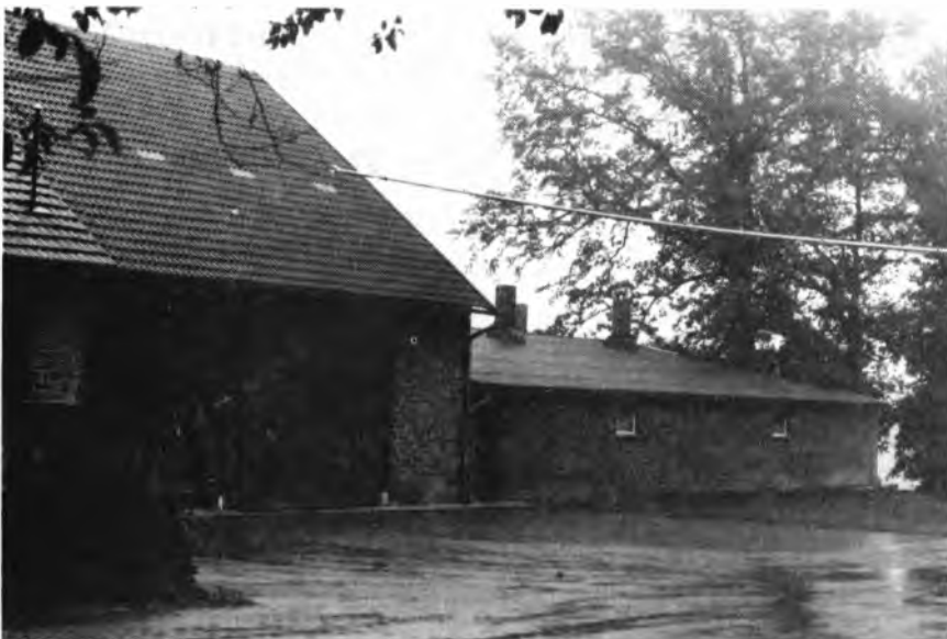
Abb. 2: In der an den Stall- neubau angrenzenden Scheune sind Futter- lager und Flüssig- fütterungsanlage unter- gebracht
