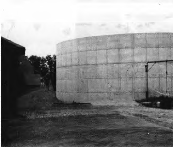
Abb. 6: Hochbehälter (990 m 3 Inhalt) mit Vorgrube und stationärer Kreiselpumpe
