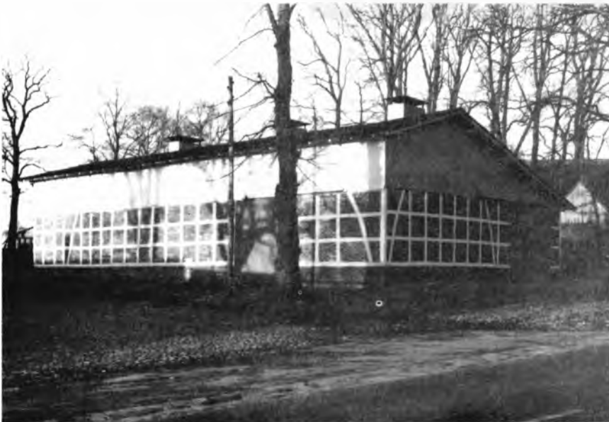
Abb. 2: Die Außengestaltung der zum Schweinestall umge- bauten Scheune wurde nicht verändert
