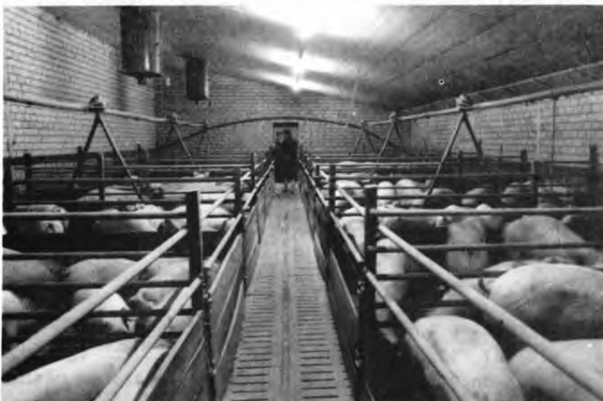
Abb. 3: Mastabteil mit schräg- geführter Decke, Voll- spaltenboden, Flüssig- fütterung und verstell- barer Zuluftführung an der Traufseite
