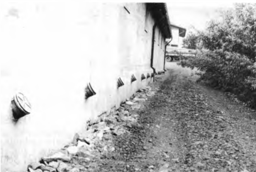
Abb. 3: In jedem Abteil sind Vorrichtungen zum Spülen der Mistkanäle eingebaut
