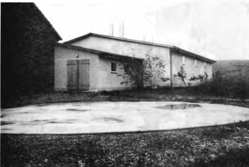
Abb. 3: Maststall wurde über einen Zwischenbau ge- schickt an die Scheune angeschliedert. Im Vorder- grund befindet sich der befahrbare Tiefbehälter
