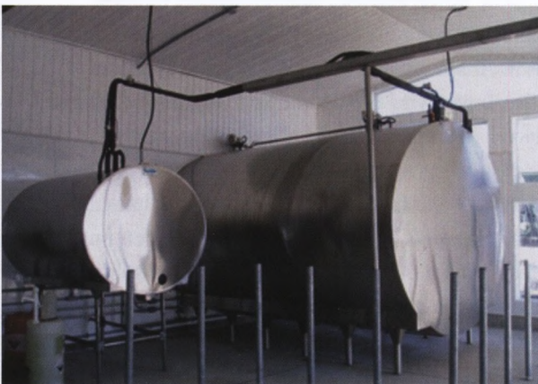
Abb. 9: Puffertank für die Überbrückung der Leerungs- und Reinigungszeiten des Hauptmilchtanks (Foto: Häußermann)
