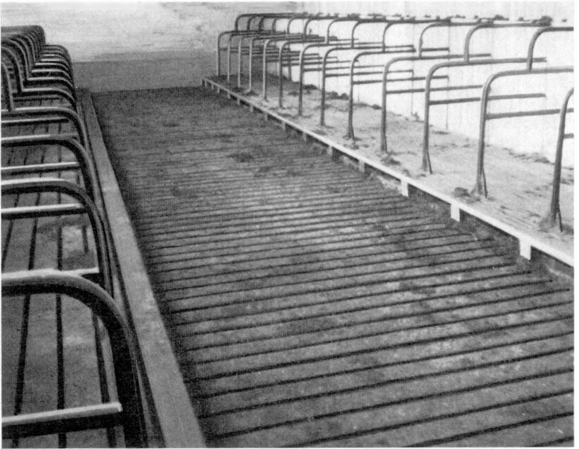
Abb. 73: Liegeboxenlaufstall mit Ganz-Spaltenboden, am Gang für Mastkälber (rechts). Diese Boxenlänge ist verstellbar
