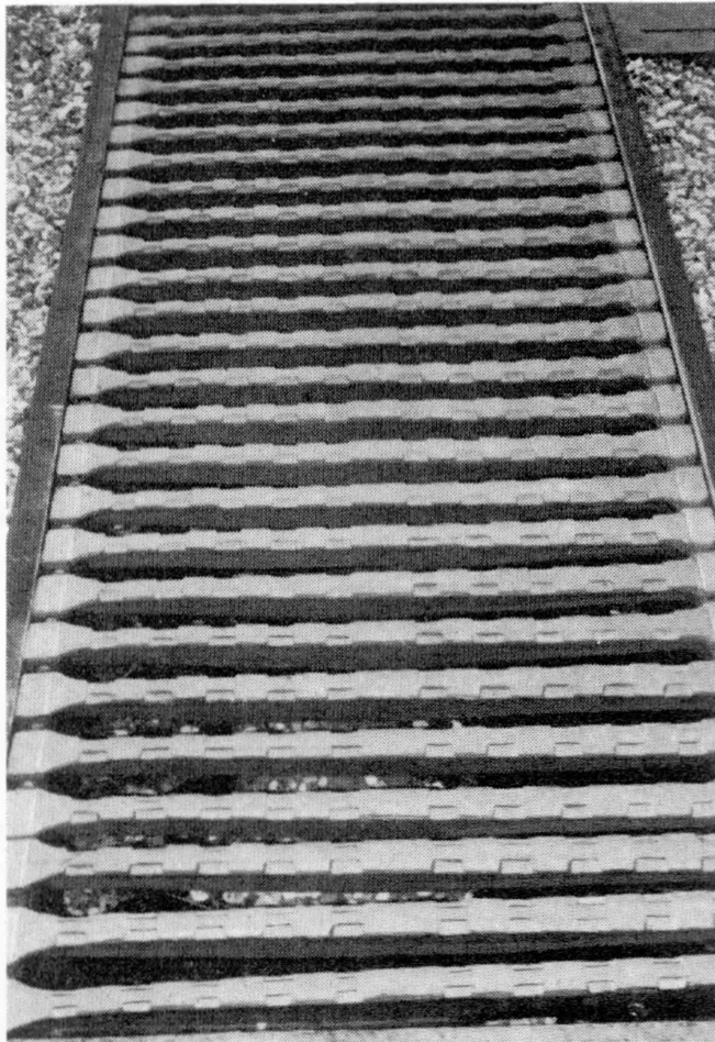
Abb. 9: Rostsonderform. Hier sind keine geschlossenen Roste sondern Einzelstäbe aus Gußeisen quer über den Kanal gelegt worden (Abstand ist verstellbar). Die Stäbe verlaufen nicht in Arbeitsrichtung, sondern quer, wodurch das Rostreinigen erschwert wird
