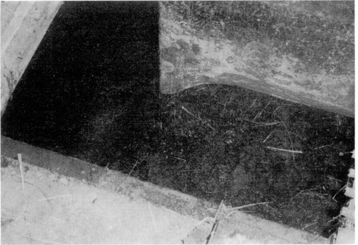
Abb. 54: Der Treibmistkanal (im Vordergrund mit Ablauf seitlich). Der Treibmist scheint fast trocken zu sein, und doch läuft er kontinuierlich in den Seitenkanal ab
