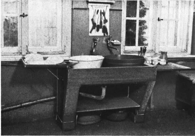
Spülstein aus Terrazzo, nach Einsetzen von Schüsseln auch als Abwaschtisch benutzbar
