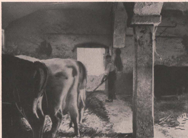
Die bei der Arbeit störende dicke Säule mitten im Gang ist ersetzt durch einen eisernen Träger.
