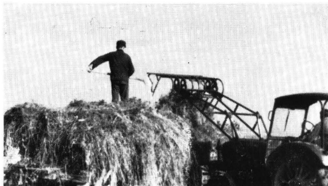
Abb. 1: Wäre es nicht praktischer, statt des Mannes auf der Fuhre ein Ladegatter zu verwenden?
