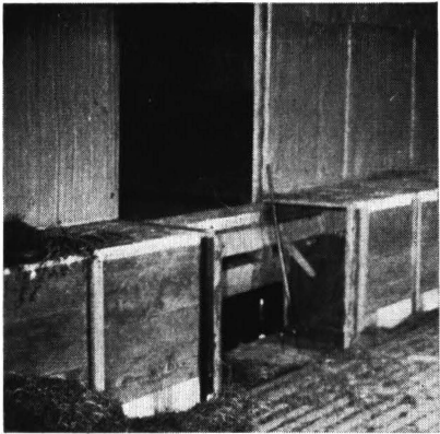
Abb. 1 b: Decken- und Seitenteile des Belüftungs-Kanales werden entfernt, um den Abwurf in die Futtertenne freizulegen
