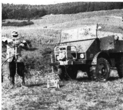
Abb. 2: Stromerzeuger mit Elektrobohrgerät und Gebläse
