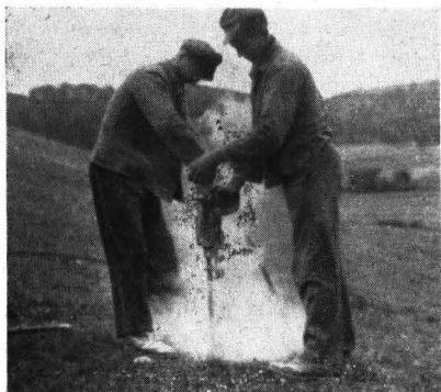
Abb. 1: Prebluftbohrgerät bei der Arbeit
