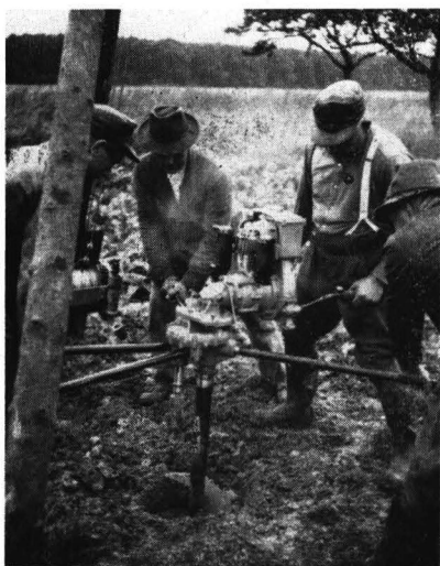
Abb. 3: Tragbares Erdbohrgerät zur Bohrlöcherherstellung und zur Herstellung von Tiefendrainagen
