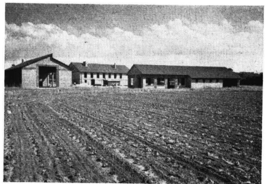
Abb. 4: Neubau des Schlepperprüffeldes Darmstadt in Kranichstein
