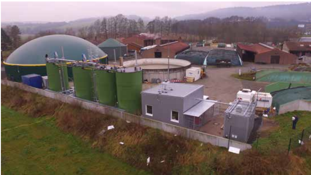
Abb. 3: Testplattform des Fraunhofer IEE mit hochflexibler Biogastechnologie (ReBi, links im Bild) und Power-to-Gas Testzentrum mit Elektrolyse (rechts im Bild) (© Fraunhofer IEE)
