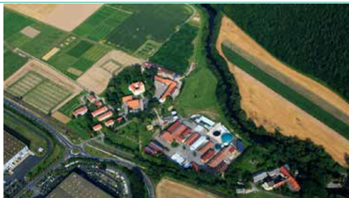
Hessisches Biogasforschungszentrum HBFZ, Bad Hersfeld
