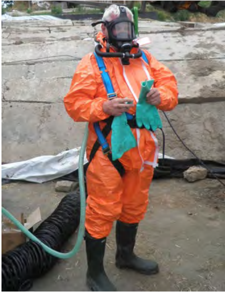
Abb. 7: Persönliche Schutzausrüstung mit Atemschutz (© APO Geopohl AG)
