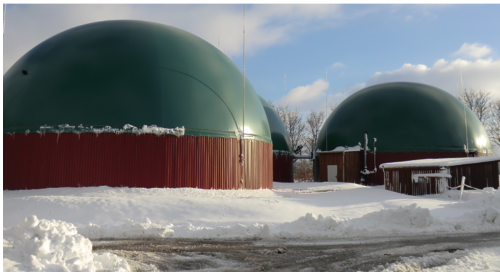
Abb. 1: Biogasanlage der Agrargenossenschaft „Bergland“ Clausnitz e.G. an der Milchviehanlage (© Ferchau)
