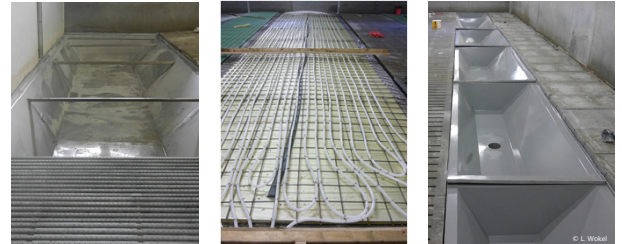
Abb. 1: Güllewannen zur Kanalverkleinerung (rechts/links), Heiz-/Kühlleitungen im Liegebereich (Mitte)
