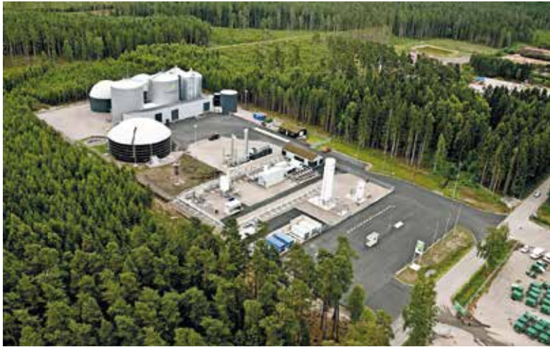
Abb. 7: Bio-LNG Anlage in Lidköping, Schweden (© lidköpingbiogas)
