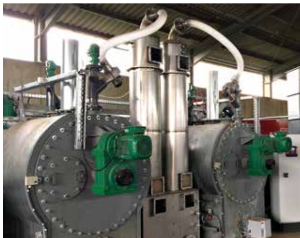
Abb. 1: Pilotanlage zur Behandlung fester Biomasse mit Branntkalk (© Daniel Baumkötter)
