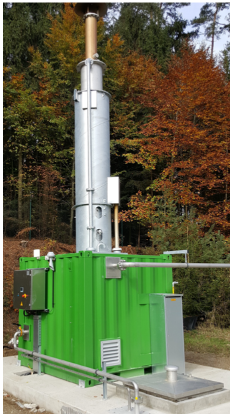
Abb. 8: Schwachgasfackel mit Gebläsebrenner und Brennluftvorwärmung zur Behandlung von Schwachgas ab einem Methangehalt von 6 Vol-% (© BMF HAASE GmbH)
