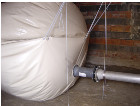
Abb. 12: Einschaliger Gassack mit Befestigungen (© Gerd Reinhold)
