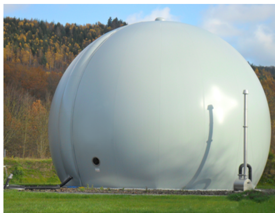
Abb. 11: Freistehender Doppelmembranspeicher zur Speicherung von Biogas (© Sattler Ceno Top-TEX GmbH)
