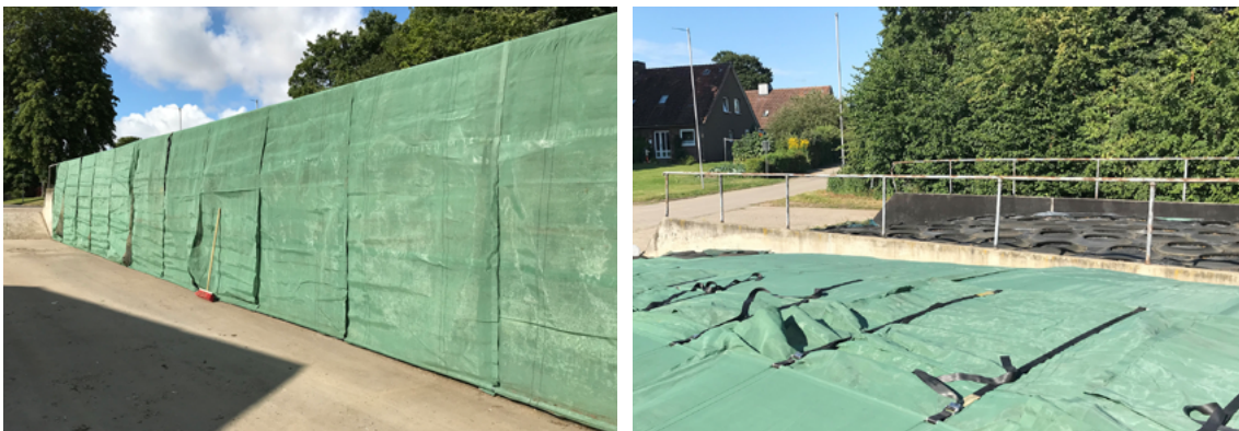
Abb. 5: Beim Abdecksystem Agritec Silage Safe (HUESKER) werden die Silowände vor der Befüllung mit 2,5 m breiten Gewebebahnen ausgestattet (links), die nach Siloschluss miteinander verzurrt werden und die Folie so auf die Silageoberfläche drücken. Nach dem „Setzen“ des Silos ist ein Nachspannen der Gurte erforderlich, um den Druck auf die Folie aufrechtzuerhalten (rechts). (© S. Ohl)
