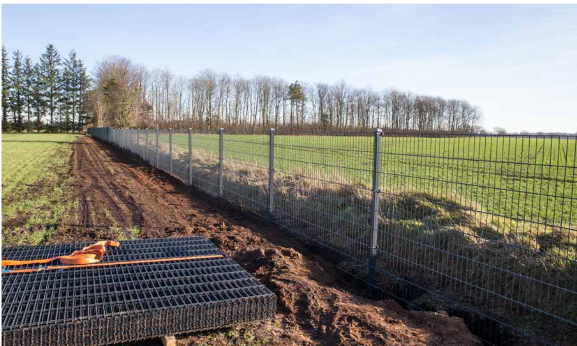
Abb. 2: Einfriedung mit Stabmattenzaun (© stock.adobe.com – Britta Kromand)
