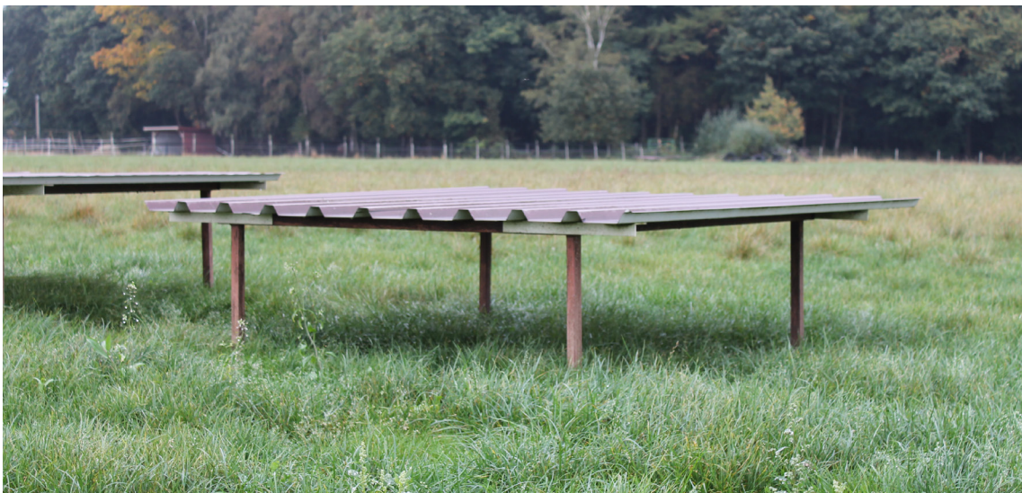
Abb. 5: Hütte bestehend aus Trapezblech und Untergestell aus Eisen (© Julia Lüssing-Griese)
